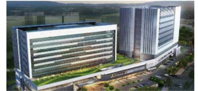
NH 통합 IT센터 (현대건설) 지하 2층, 지상 10층 연면적 91,570㎡ (약 27,800평) 규모
