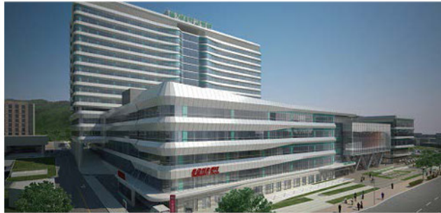
의정부 을지대 캠퍼스 (쌍용건설) 지하 5층, 지상 5층 연면적 175,500㎡ (약 53,100평) 규모
