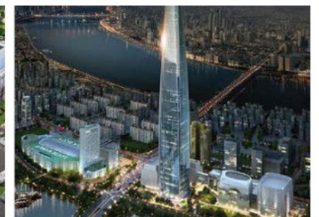
제2 롯데월드타워 (롯데건설) 지하 6층, 지상 123층 연면적 328,351㎡ 규모
