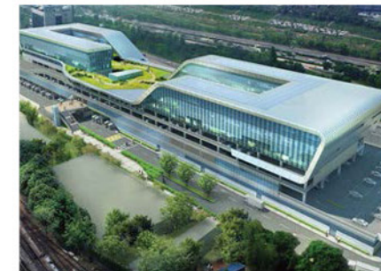
노량진 수산물 도매시장 (현대건설) 지하 2층, 지상 6층 연면적 118,346㎡ (약 35,800평) 규모
